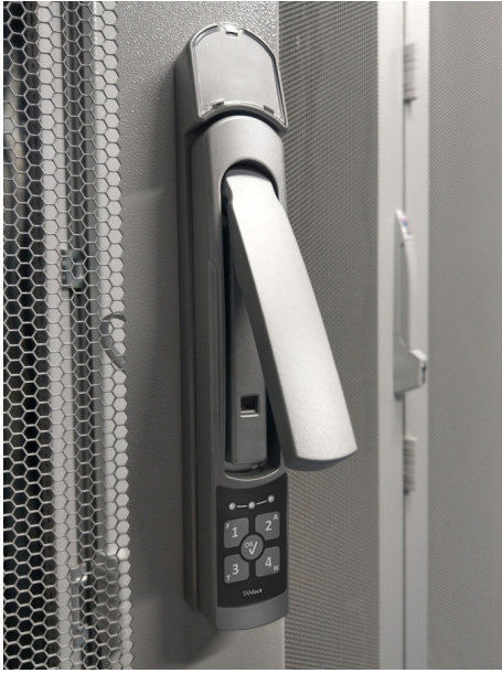
Der TANlock 3.0 bietet eine durchgängige, sichere und flexibel anpassbare Zugangsüberwachung von Server racks in Rechenzentren
